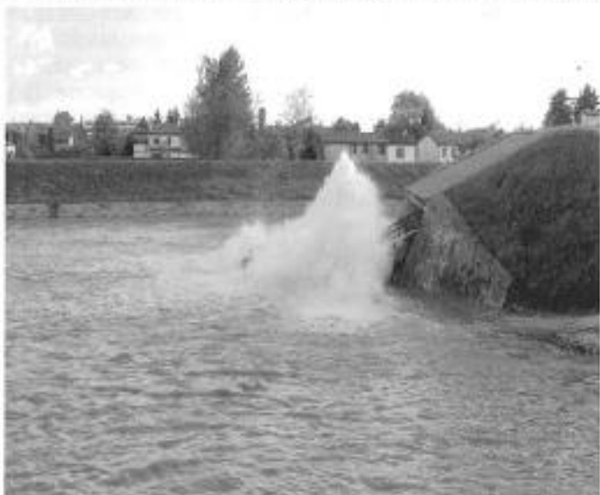
3. Vecchio Casello Idraulico di Ca' Nordio. La nuova paratia e la nuova idrovora per lo scarico in regime ordinario delle acque del Roncagette Superiore.
