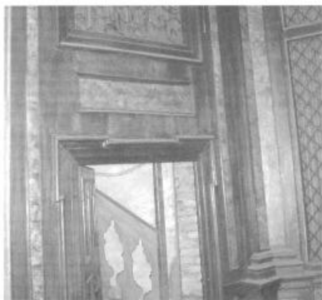
4. Particolare della porta di accesso al ballatoio.
