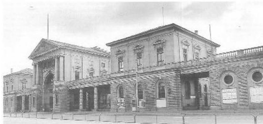
2. Facciata monumentale del Foro Boario. Sistemazione del lato sud costruito secondo il progetto del Peretti, 1913.
