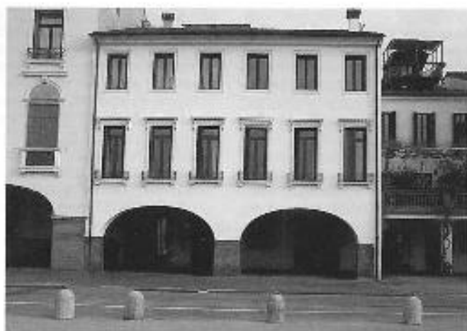
3. Padova, Prato della Valle, 10. Palazzetto Dottori Sanson (foto V. Noaro).
