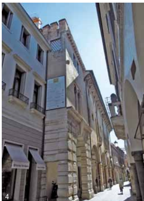
4. Scorcio del tratto di via S. Francesco con l'edificio medievale a merlatura confinante ad ovest con il Palazzo Roccabonella.
