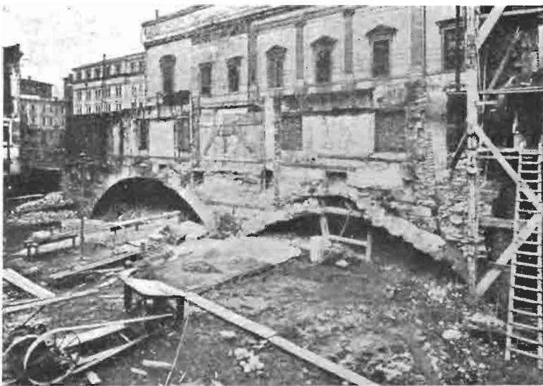
Resti del ponte romano (attuale ponte S. Lorenzo) evidenziati negli scavi del 1938, durante i lavori per la nuova sede dell'Università.
