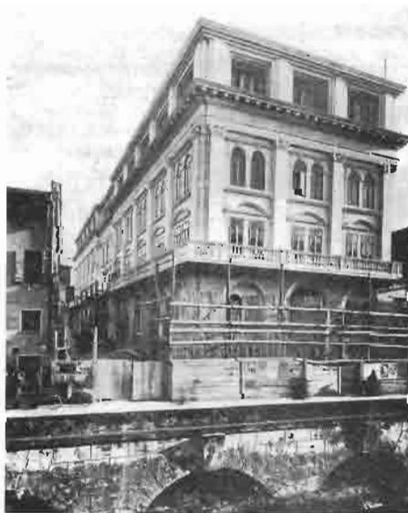
I lavori di completamento della facciata.
