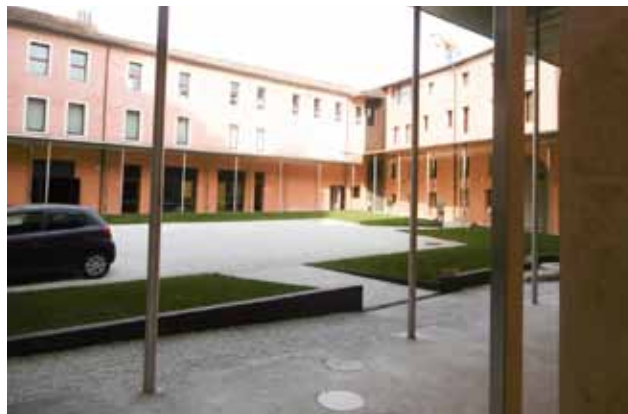
Veduta del chiostro interno, con la ricostruzione del porticato in acciaio (foto Paolo Pavan).
