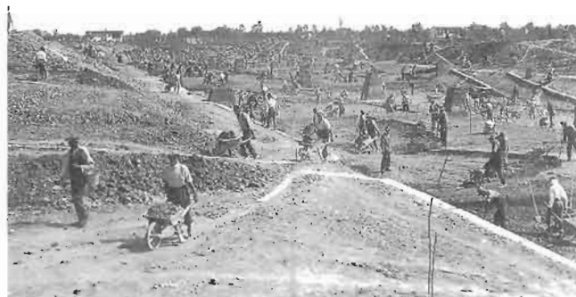
Lavori di ampliamento dello Scaricatore (anni Trenta).
