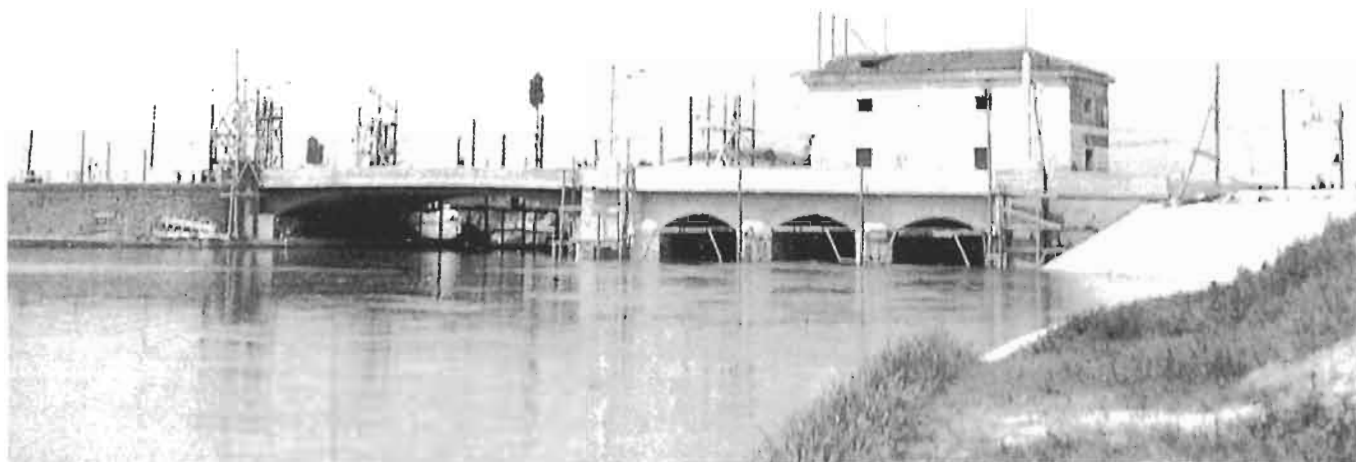
Il canale Scaricatore con la nuova arcata vista dall'argine sinistro.
