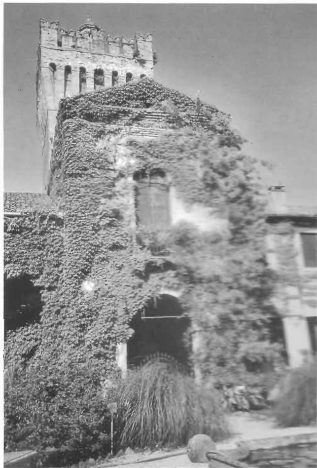
Particolare della villa a ridosso della torre medioevale di S. Pelagio. -
