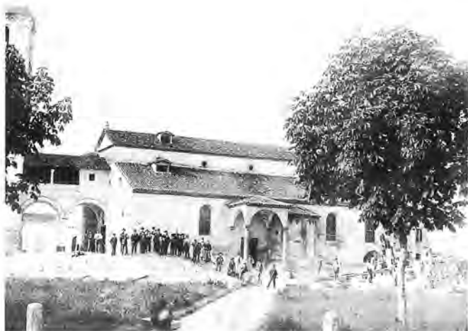
2. La chiesa nel 1888 vista da sud.
