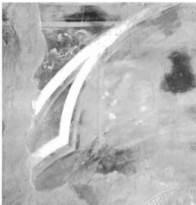
3. Abside, stuccature precedenti, particolarmente marcate nel lato sinistro (foto A. Quattrone).
