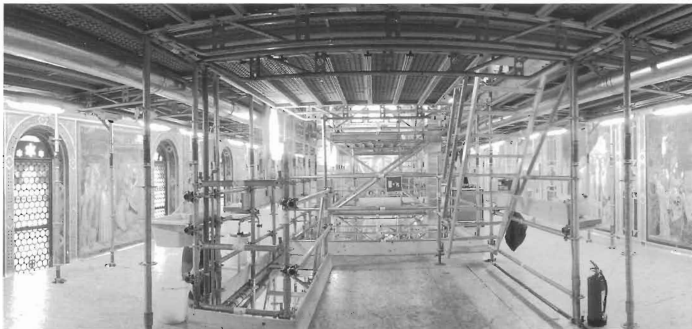
Il ponteggio nell'interno della Cappella, all'altezza della prima fascia di affreschi.
