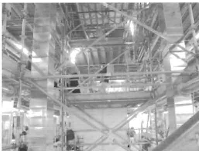
Veduta d'insieme dei ponteggi modulari che reggevano i palchi utilizzati anche dal pubblico nei giorni delle visite.
