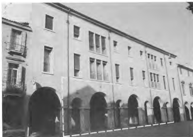
1. Edificio di corso Vittorio Emanuele II, n. 72-80, con resti del cinquecentesco palazzo Amadi (foto A. Elementi).
