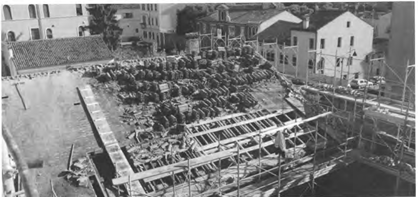
Sala 24. Fasi di smontaggio delle strutture di copertura.
