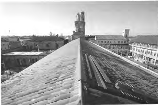
Ala Sud. La copertura ricostruita.
