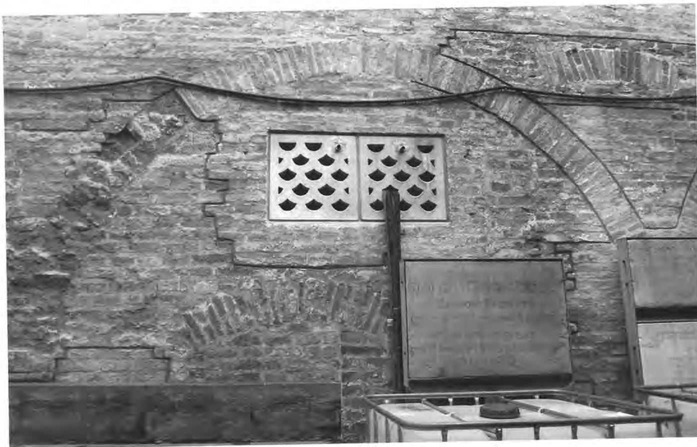
Arcate del "chostro dei canonici", nell'edificio che delimita il lato nord del cortile.
