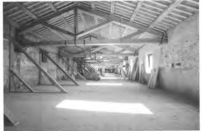
Ala Sud. Ricostruzione delle capriate di copertura.
