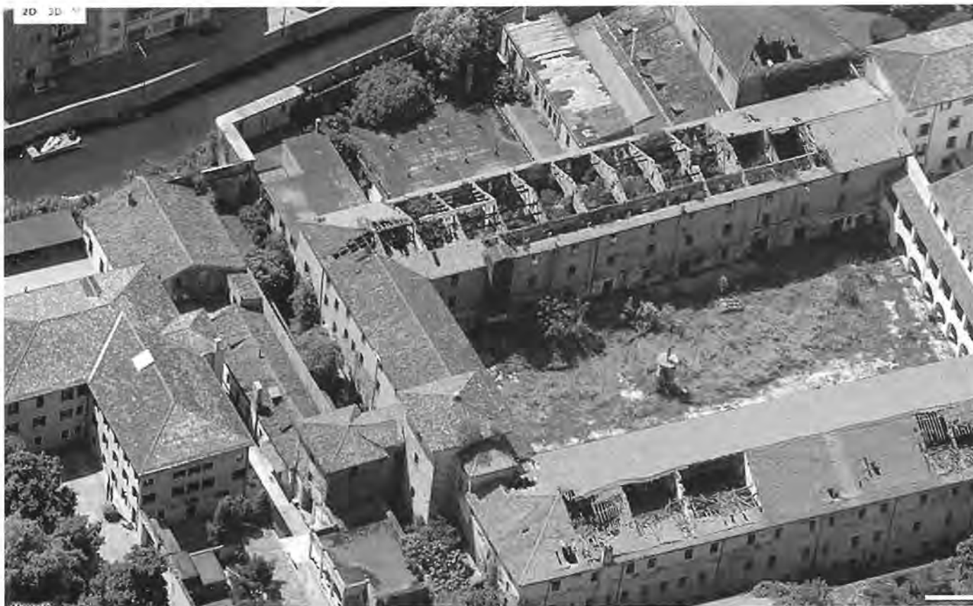
Primavera 2005. Lo stato di degrado della struttura.
