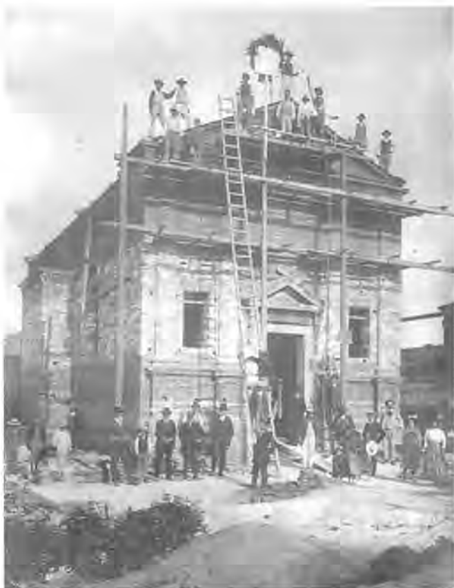
Pozzonovo, lavori in corso.
