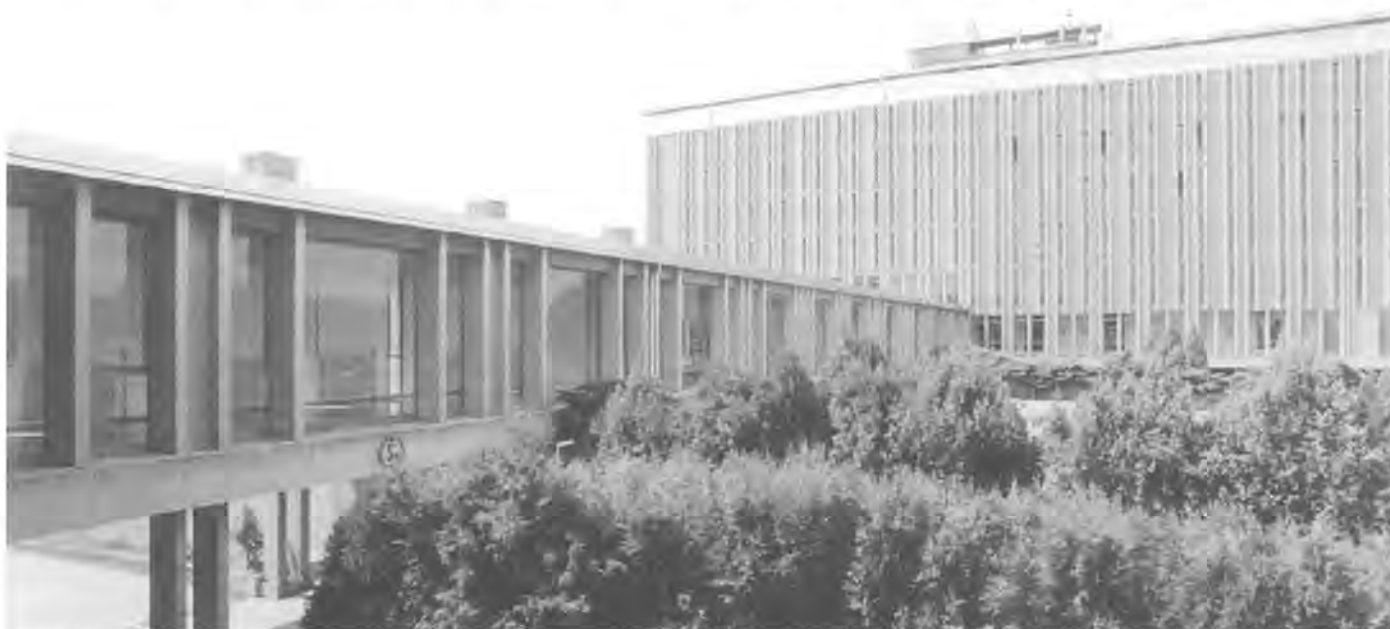
La palazzina dei professori con la galleria di collegamento all'ingresso.
