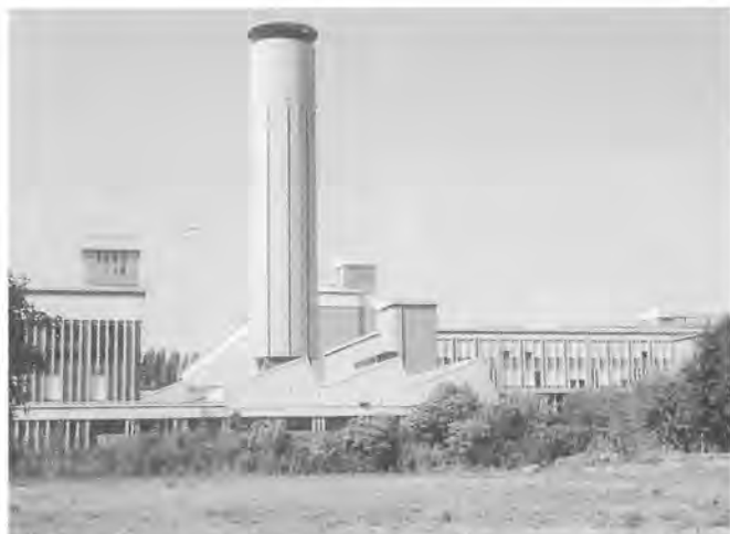
Il gruppo servizi del complesso visto da sud.
