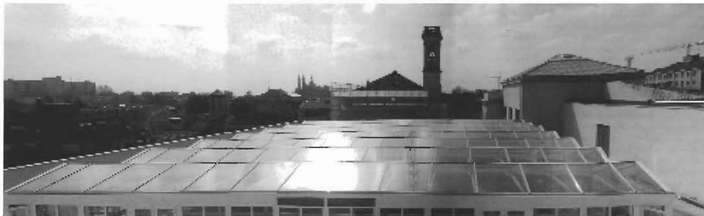
La vetrata di copertura vista verso sud. In secondo piano la chiesa di S. Gaetano con le impalcature del cantiere di restauro; sullo sfondo le guglie della Basilica del Santo.
