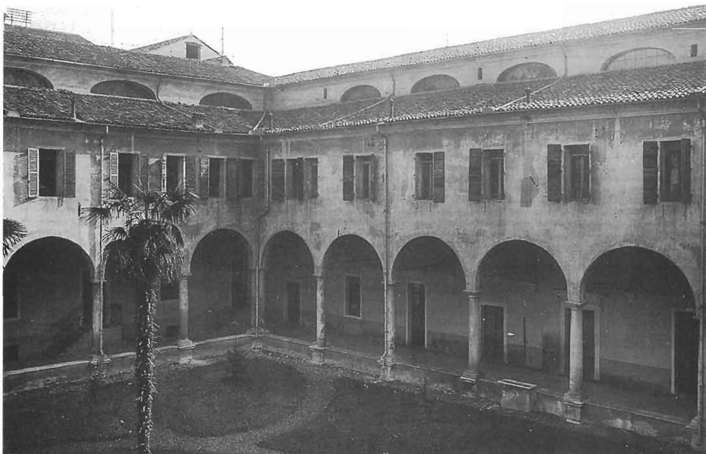
L'angolo nord-est del chiostro prima della ristrutturazione dei locali occupati dal Genio Civile.
