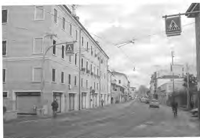
Come si presenta l'ex Pastificio Benacchio ai nostri giorni. L'aspetto complessivo si è salvato anche se sono spariti i fregi sulle finestre. A piano terra le maggiori modifiche per l'apertura delle vetrine dei negozi.
