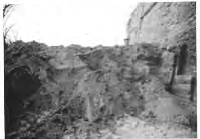
I primi scavi del 1986 per valutare le caratteristiche del terreno gole-nale.
