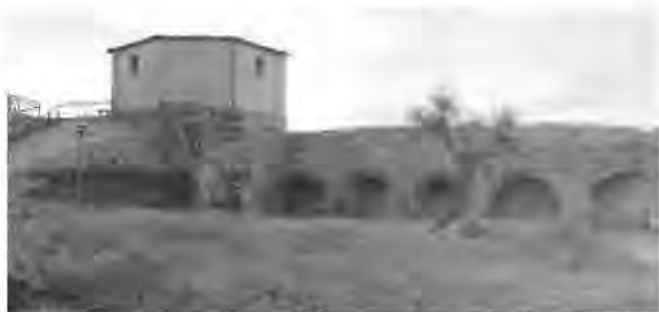
Il torrione visto dall'interno. Si ipotizza che i cinque fornicci che si dipartono da esso siano stati gli archi attraverso i quali passava l'acqua del fossato interno del Castelnuovo. Probabilmente, nella condizione primitiva, costituivano la via d'accesso al bastione stesso.
