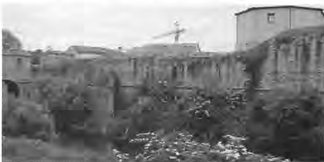
Il torrione del Portello vecchio visto dall'esterno.
