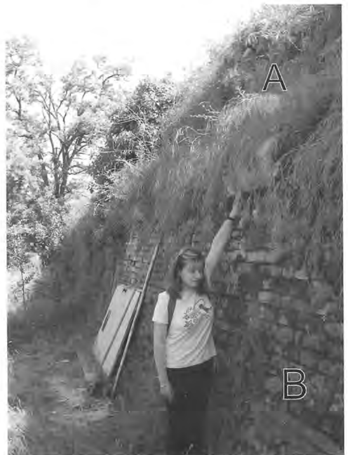
Particolare della cortina muraria interna del Castelnuovo. Sono indicati alcuni conci del cordone (A) e della camicia (B).
