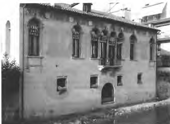
Casa Sanavio, prima sede della scuola: facciata sul Naviglio.
