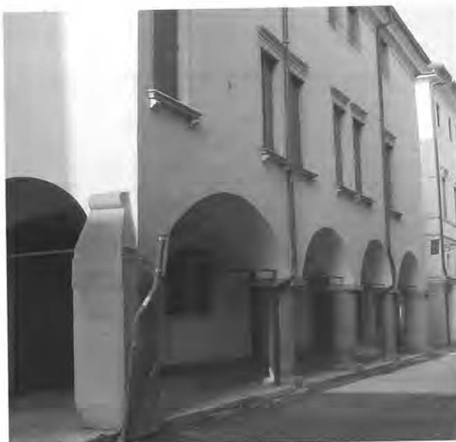
2. Padova, Via Altinate, n. 126-130. Facciata principale del palazzo Zacchi (foto V. Noaro).
