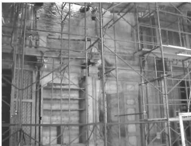
Interno della parete d'ingresso della biblioteca, in attesa di restauro.
