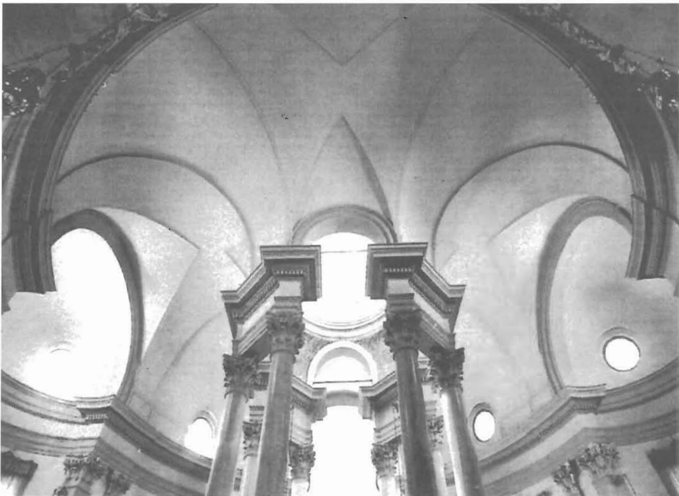
Interno dal vestibolo, dopo il recente restauro.
