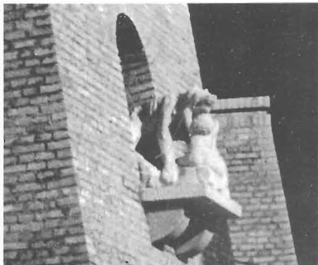
Scultura raffigurante la lupa che gioca coi gemelli su una delle torri di accesso al teatro detto dei diecimila (1939-40), che sorgeva presso il Bonservizi.
