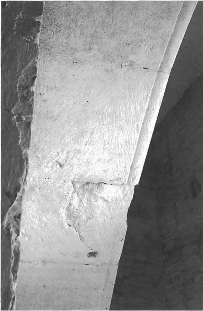
5. Porzione d'arco della porta comunale all'interno dell'Osservatorio Astronomico.
