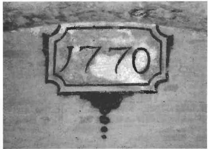
4. Data dipinta all'interno dell'ambiente cieco sottostante l'attuale piano terra della torre.
