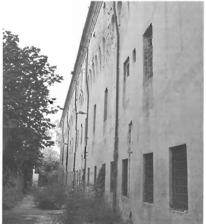
2. Scorcio del lato di tramontana del Castello, verso la chiesa di s. Tomaso. Sono visibili i beccatelli aggettanti che un tempo sostenevano il parapetto del cammino di ronda, dotato di merlature, ora inglobate nella costruzione.
