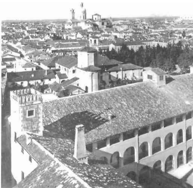
8. Particolare dell'ala nord, verso il cortile interno, negli anni venti del '900, prima del pesante inserimento di un telaio di travi e pilastri in calcestruzzo, realizzato negli anni cinquanta (vedi fig. 6).
