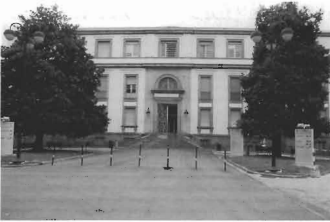
Ingresso all'ospedale (foto arch. Bussadori).
