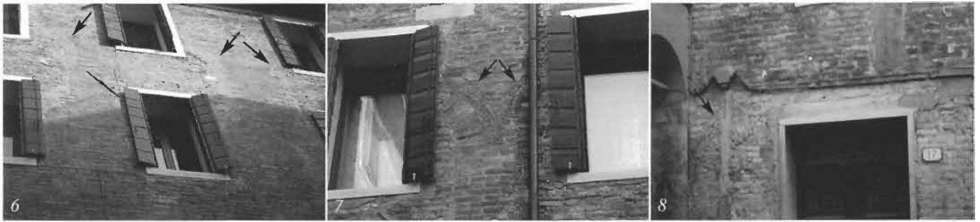
6. Padova, palazzo Da Baone, Via dei Soncin n. 10. Tracce dei tre finestrati nella parte alta della facciata. 7. Idem, Via A. Gritti, n. 17-19. Tracce di due finestre, all'altezza del primo piano. 8. Idem, Via A. Gritti, 17. Traccia del portale d'ingresso (le tre foto sono di A. Elementi).
