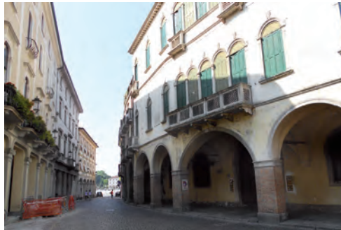
L'attuale palazzo Da Zara in via Umberto I, un tempo casa del Beolco.
