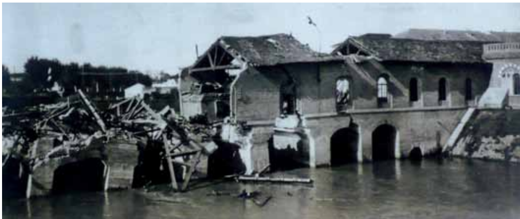
Veduta a valle del manufatto dopo il crollo avvenuto nel 1919.
