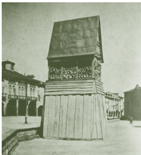
1. Padova, piazza del Santo: struttura protettiva del Gattamelata con tetto in legno e lamiera (Padova, Biblioteca Civica, R.I.P. XI 3407).
