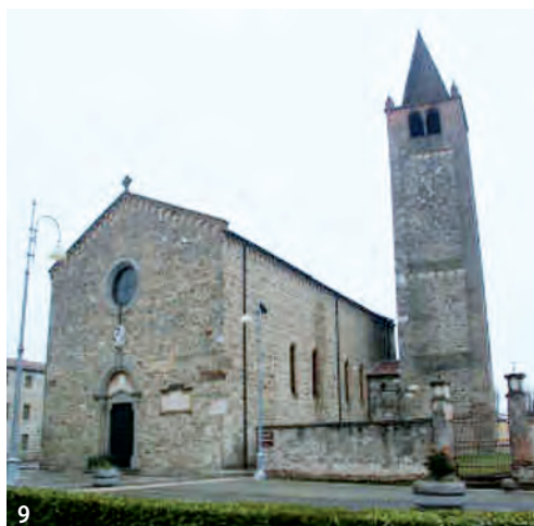
9. La facciata dell'Abbazia di S. Stefano a Due Carrare.
