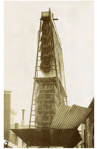
2. Il condensatore a pioggia dell'impianto frigorifero nella fabbrica di via Falcone.
