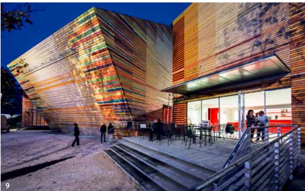
9. Veduta esterna dell'Auditorium del Parco a L'Aquila (ph. Stefano Goldberg - Publifoto).
