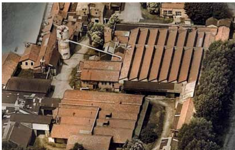
Foto aerea dello stabilimento nella sua ultima sistemazione.
