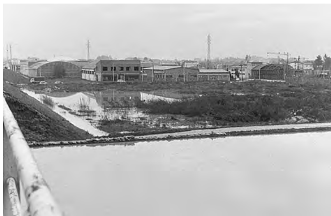
3. Piena del 4-5 novembre 1966. Zona industriale di Padova. Allagamenti in aree adiacenti al Piovego (foto tratta dagli archivi della Z.I.P.).
