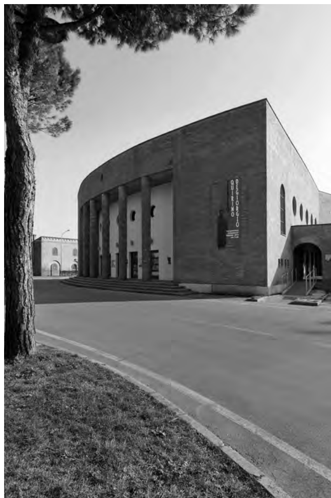
Scorcio del teatro di Vigonza, dopo il restauro (foto di Francesco e Matteo Danesin).
