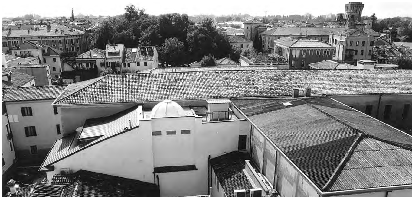
5. Veduta da nord dell'ala dell'ex monastero di Sant'Anna su via Brondolo, che evidenzia la sopraelevazione deliberata nel 1920, l'ultimo intervento del 2006-07 e il volume interno delle palestre.
