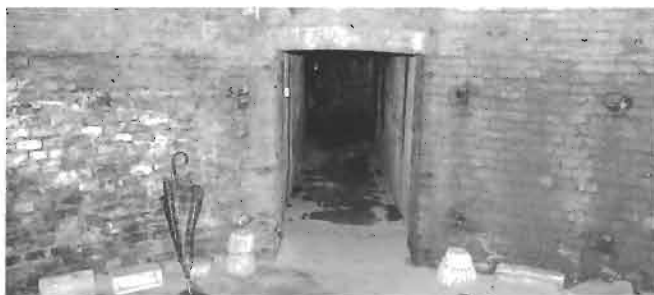
Interno della ghiacciaia del palazzo Treves.
