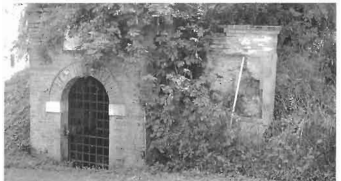
Ghiacciaia Bugia del Comune di Abano Terme, prima dell'inizio dei lavori di restauro (foto Ufficio Tecnico comunale).
