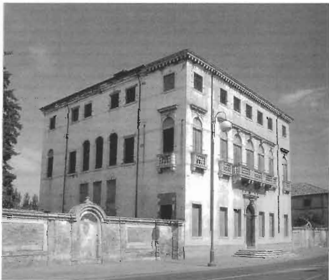
Scorcio della facciata d’ingresso di Villa Priuli a Piove di Sacco.
