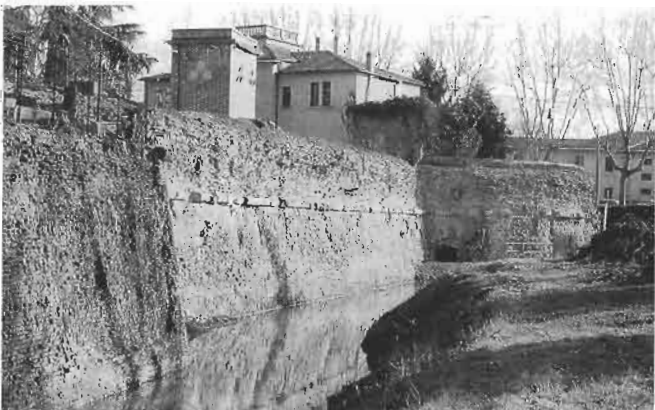
Il torrione della Saracinesca visto da nord con la bocca della cannoniera per spazzare la fossa verso S. Giovanni. A destra lo sperone sporgente della cortina.
