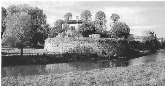
Il torrione Venier ripreso da est con sopra la scuola all'aperto Enrichetta Luzzato Diena. I sedimenti non più allontanati hanno interrato tutta l'area a destra fino al Castelnuovo.
