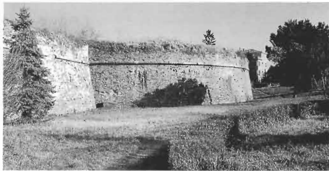
Il torrione di Pontecorvo da sud. Il giardino ondulato è piacevole, ma altera la percezione della profondità della fossa e dell'altezza delle cortine. L'arco della cannoniera sull'angolo di fianco del bastione s'intravede appena.
