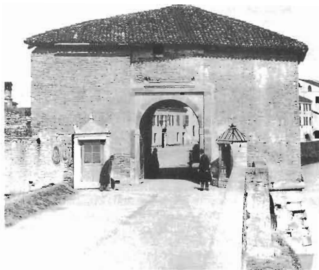
4. Porta Saracinesca prima della demolizione.
