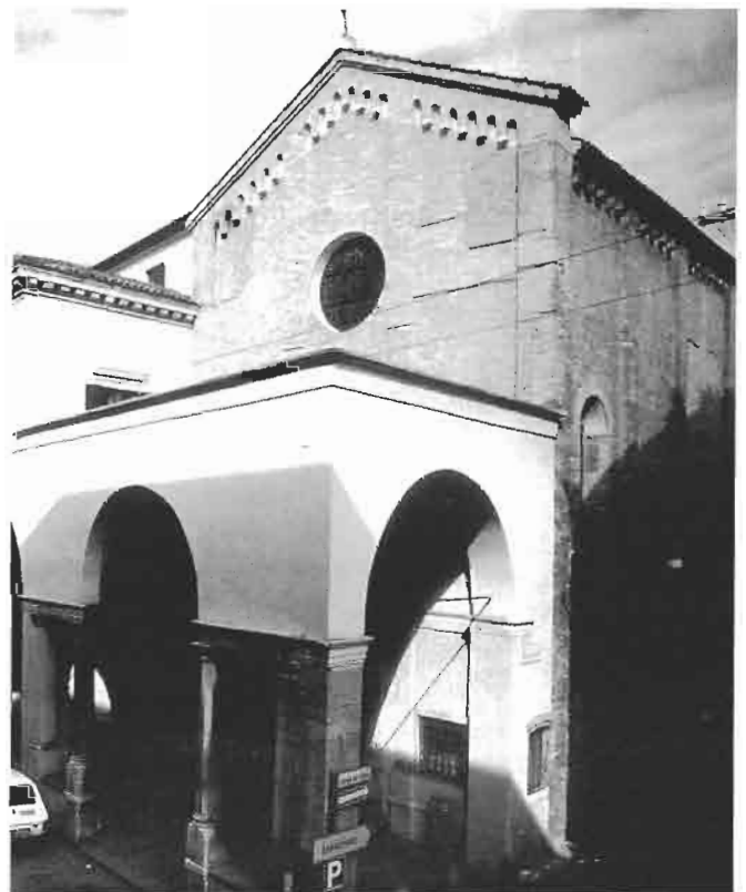
2. Padova, Sant'Antonio di Vienne; prospetto attuale inglobato dal portico monastico cinquecentesco di Andrea da Valle.
