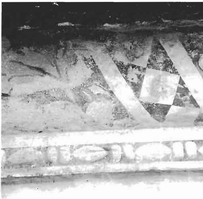
2. Salone, facciata sud, cornicione, particolare.
