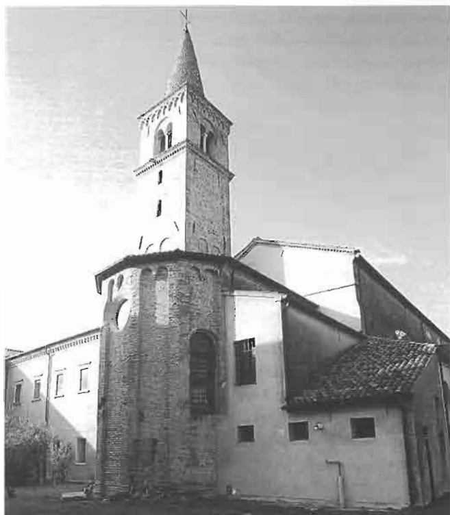
La torre campanaria e il circuito absidale di impianto romanico-gotico.
