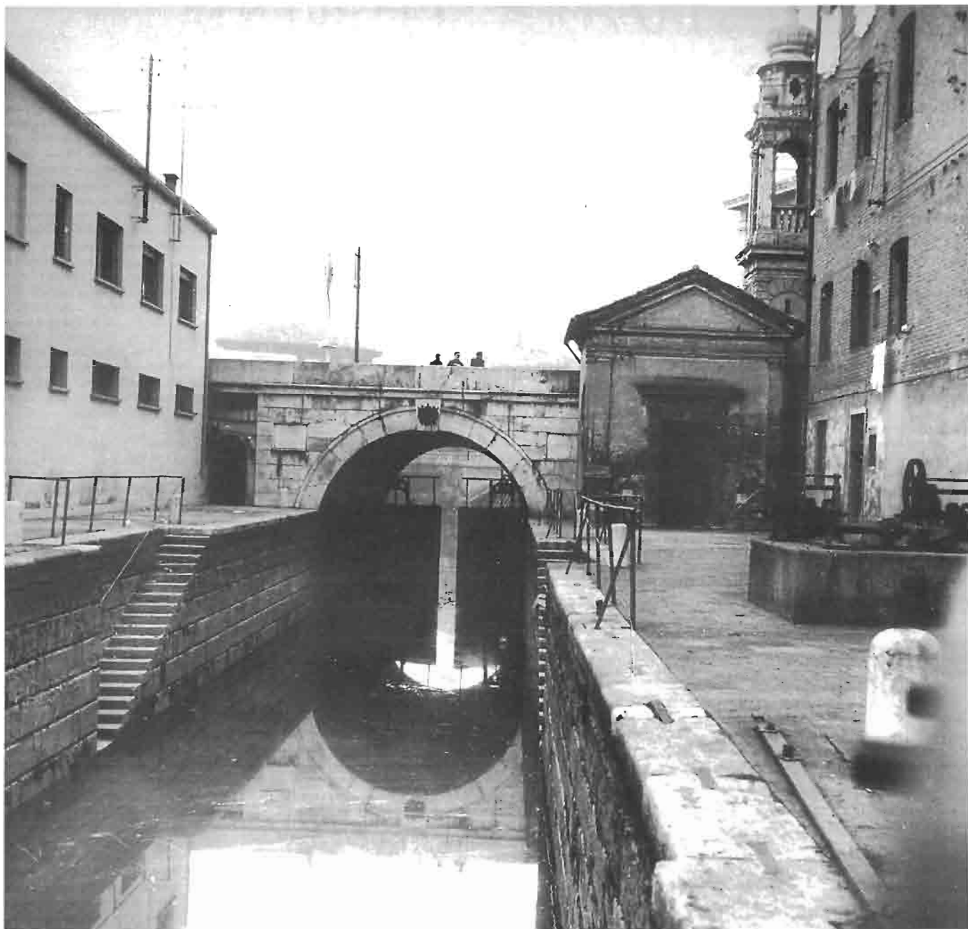
La conca idraulica come si presentava prima delle demolizioni.
