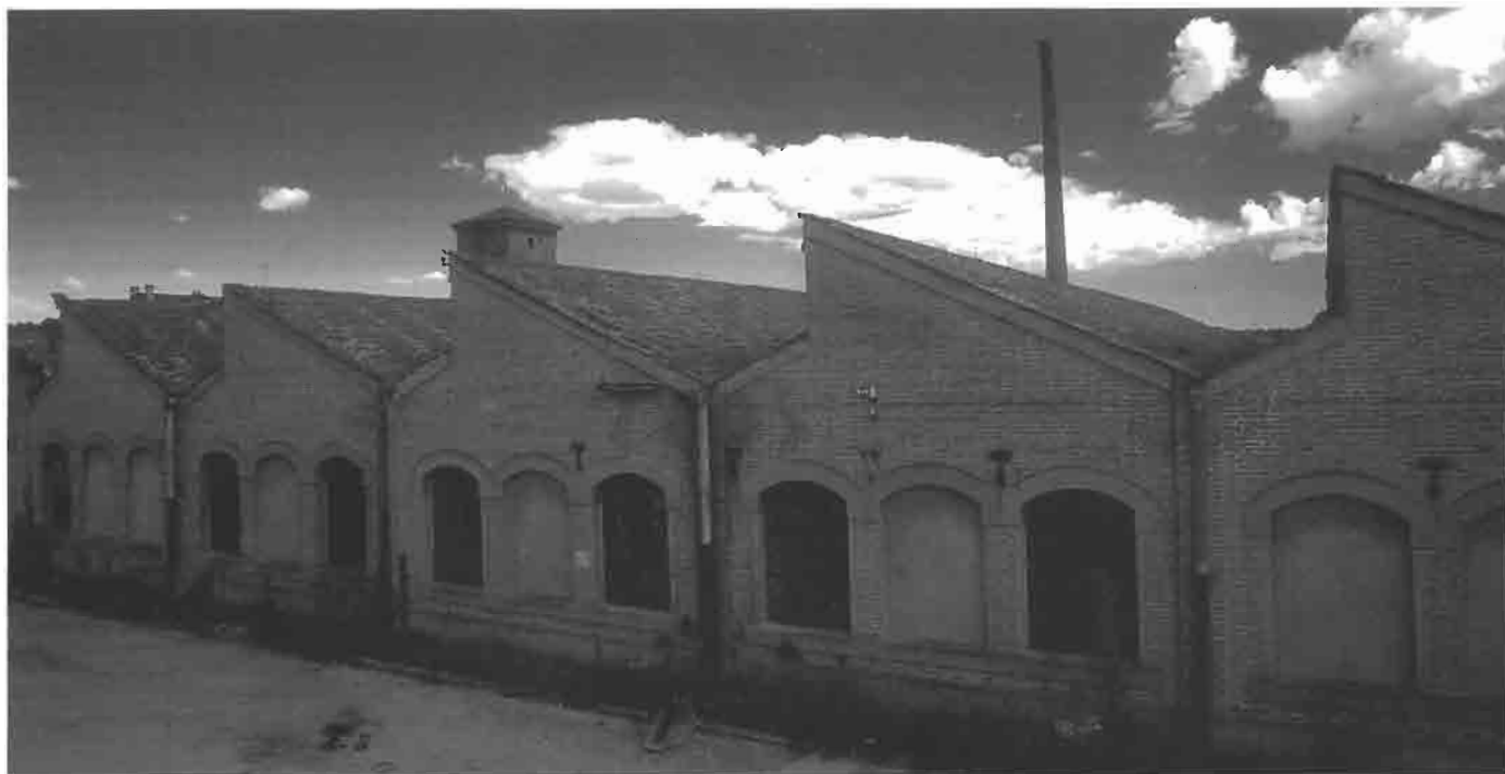
Stato attuale di alcuni edifici dello jutificio, ormai in disuso.
