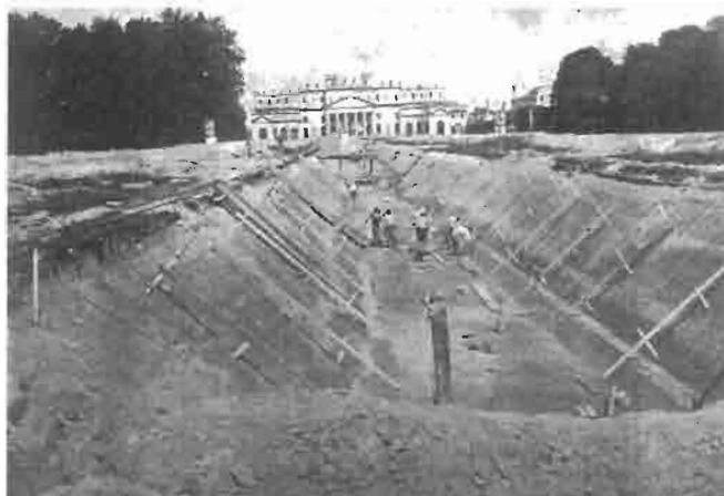
Costruzione della vasca nel parco di Villa Pisani a Strà.
