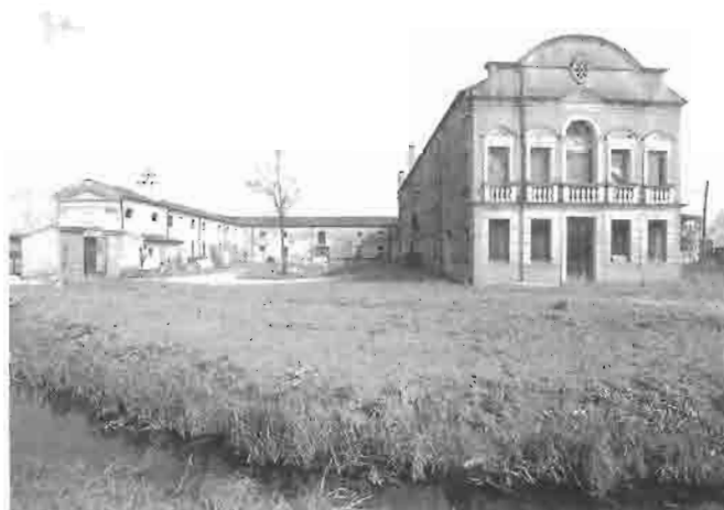
Il complesso edilizio di Ca' Ponte, sulla "strada bassa" tra Reschigliano e Cadoneghe (foto già pubblicata nel n. 44).
