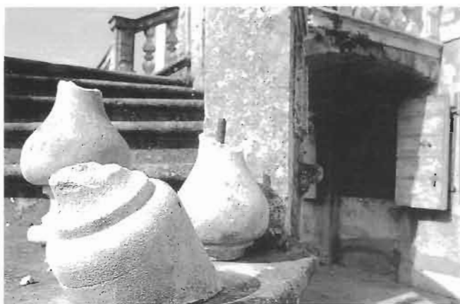
Villa in abbandono in località Vò vecchio. Foto di Alberto Cortez.
