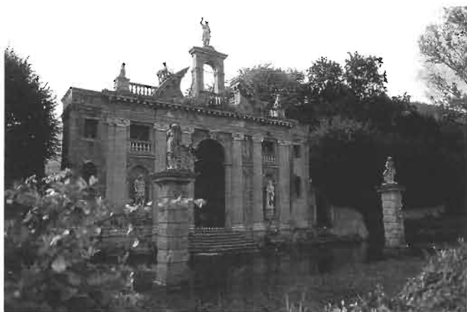
Bagno di Diana, prospetto esterno.
