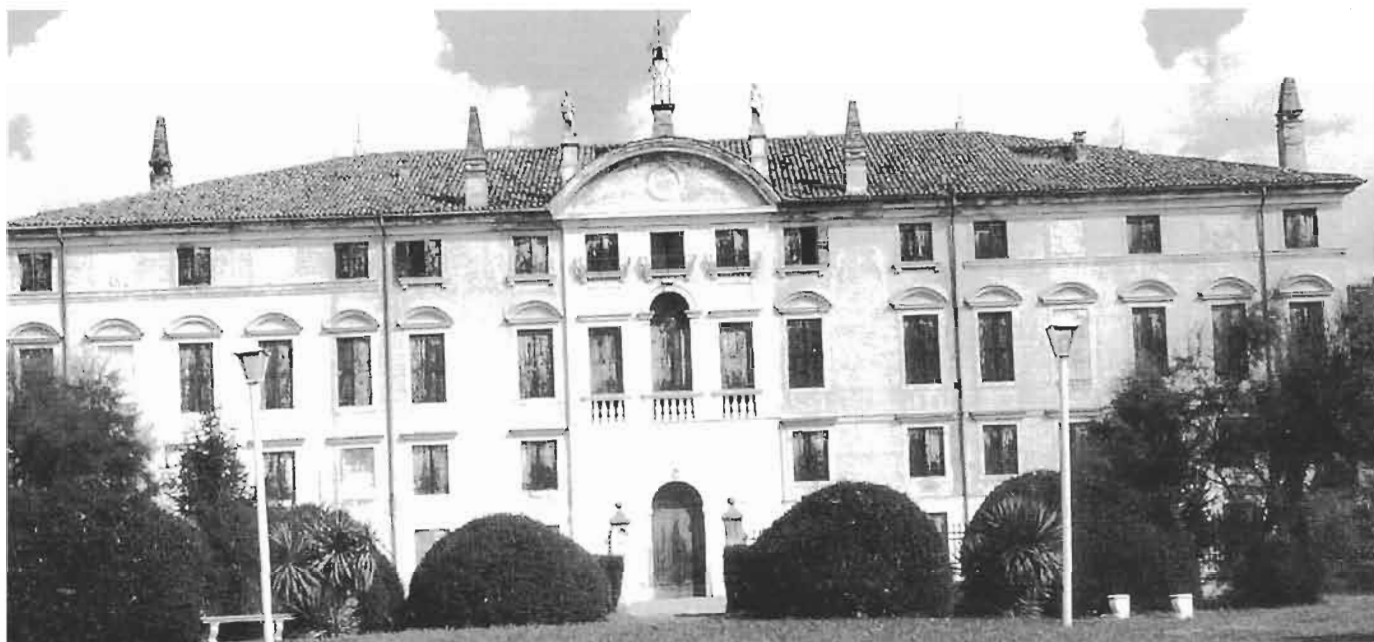
Villa Correr a Casale di Scodosia. Il restauro riguarda anche l'adeguamento degli impianti tecnologici.
