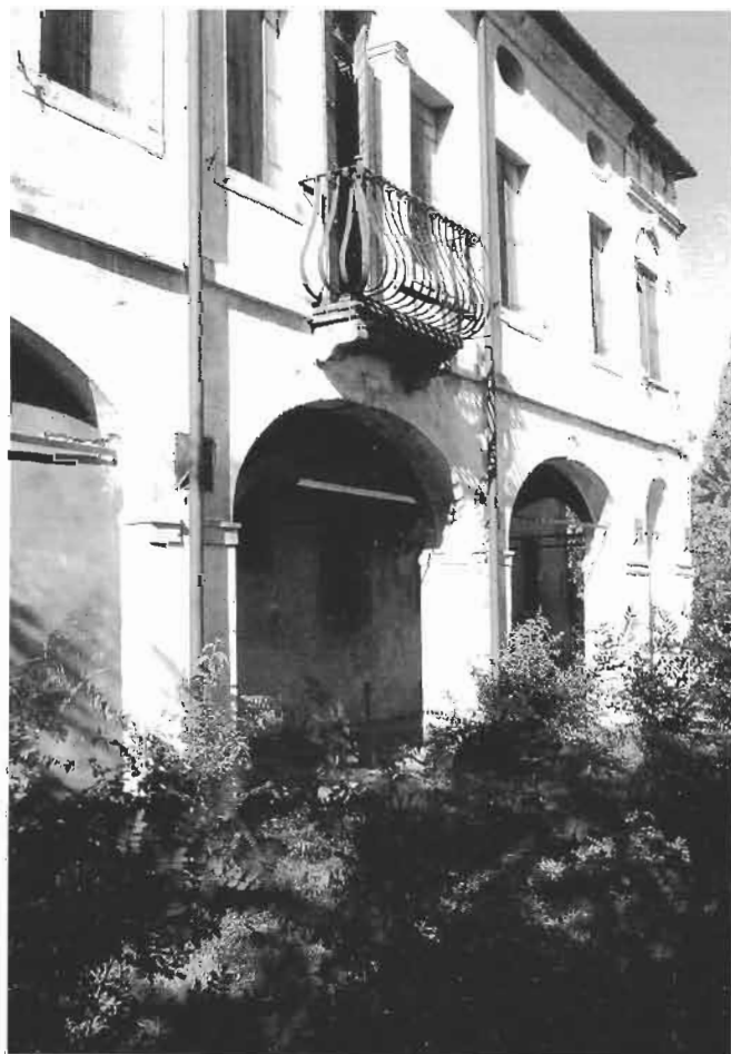
Villa Mantua Benavides. Facciata meridionale, prima del restauro.
