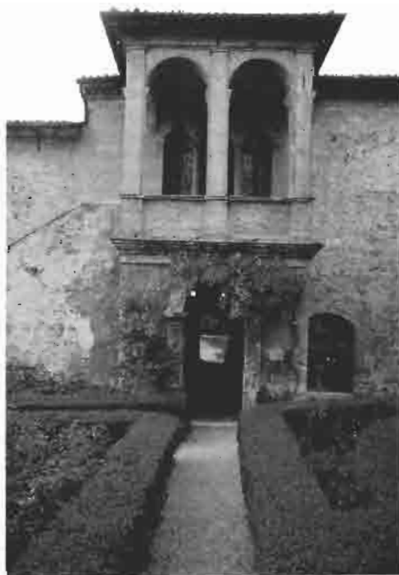
1. Arquà. Casa del Petrarca. Particolare della loggia d'ingresso, aggiunta nel '500.
