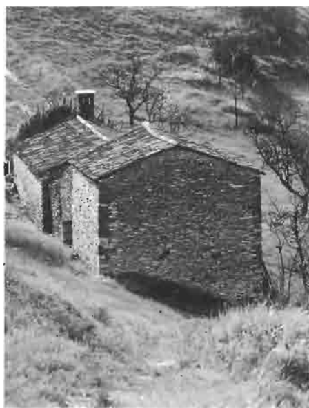
1 Rustico costruito in scaglie di pietra, ora abbandonato.
