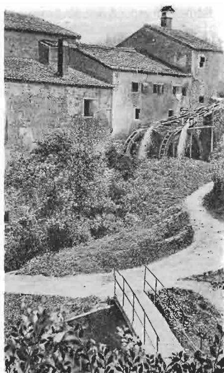
Torreglia: mulini "a coppedello" sul rio Calcina.
