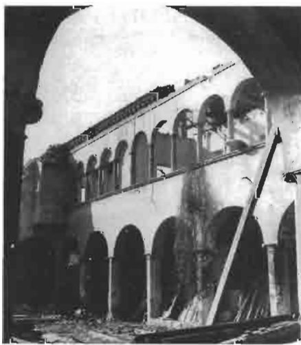
1 Quanto restava del chiostro del monastero, prima del recupero.
