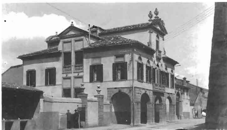
Il palazzo che ospita l'Istituto di Costruzioni marittime in via Ognissanti, già sede dell'Orto agrario.
