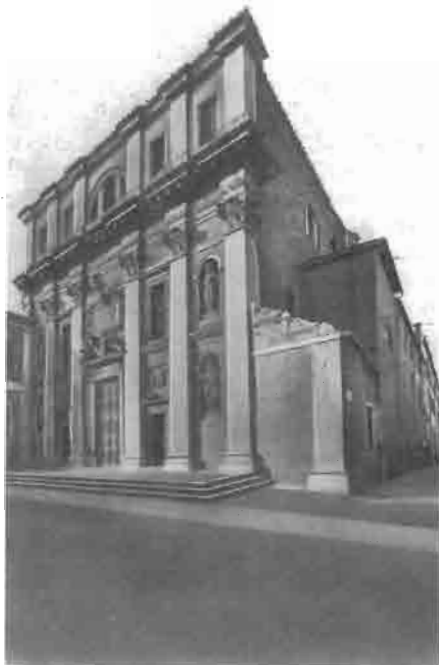
Facciata della chiesa di S. Gaetano, da via Altinate.
