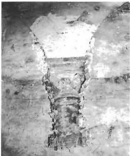
6 Colonna con capitello trecentesco ritrovata nella muratura della casa di p. Capitaniato, angolo via dei Carraresi.
