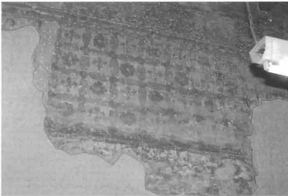
6 Padova, Gabinetto di Lettura, sala distribuzione. Paramento decorativo (sec. XIV).
