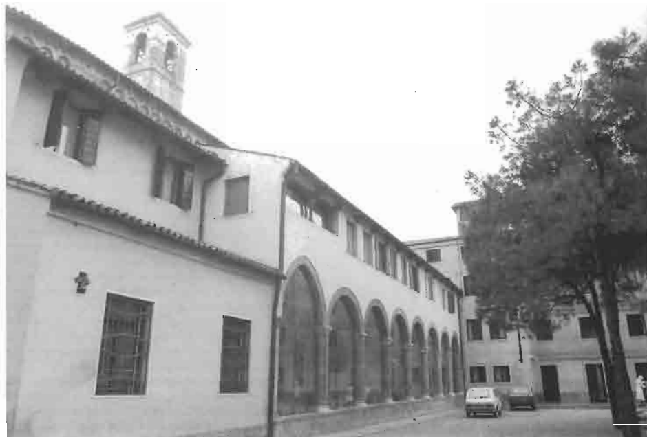
2 Un'immagine di quello che è rimasto del vecchio chiostro. Da notare un secondo ordine di colonnine che formavano probabilmente un loggiato aperto sopra il portico.
