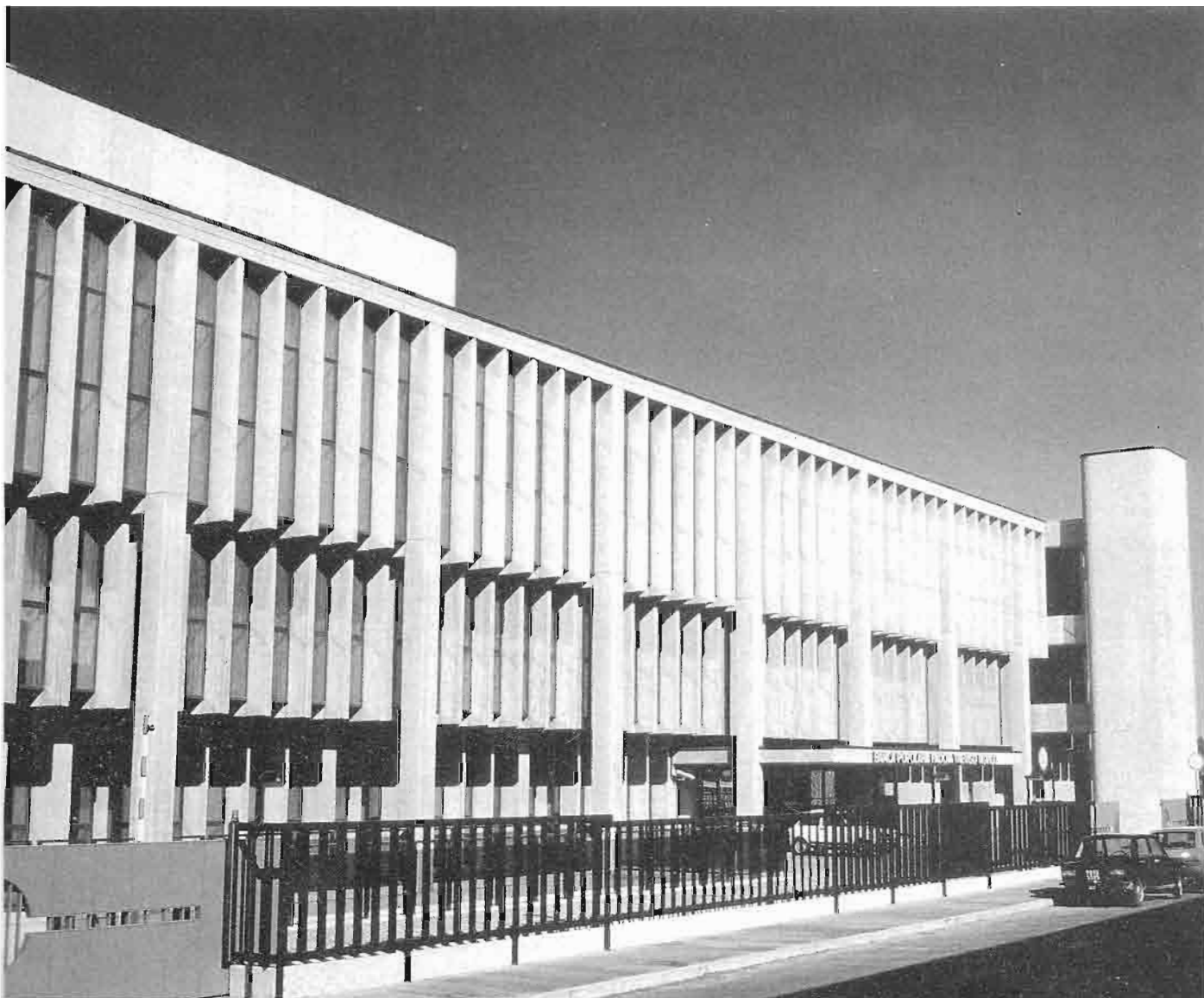
E. Bandelloni (1978-80). Banca Popolare di Padova, Treviso e Rovigo. Centro servizi. Via Transalgardo. Padova
