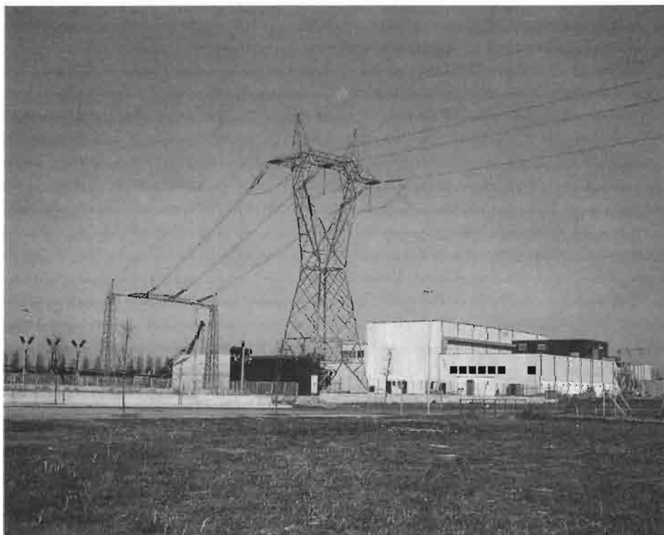
5 L'attuale aspetto degli edifici.
