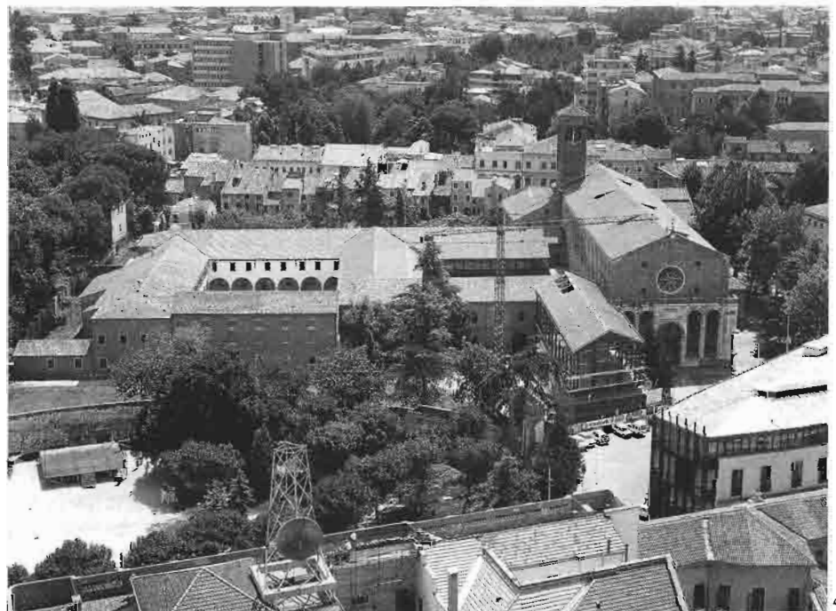
5 Veduta panoramica del complesso con l'avancorpo in costruzione (foto Fincato).
