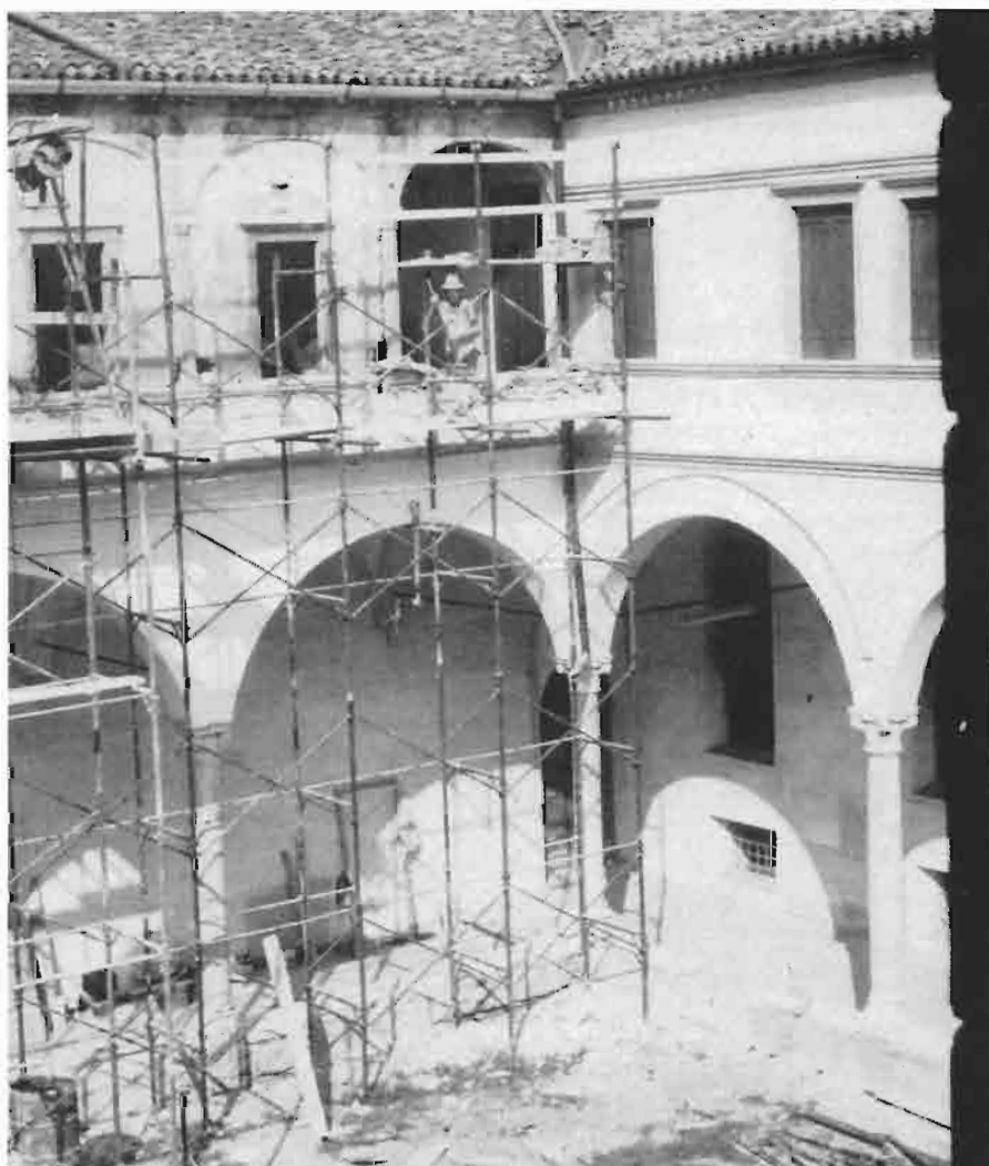
Il Chiostro durante i lavori di restauro.
