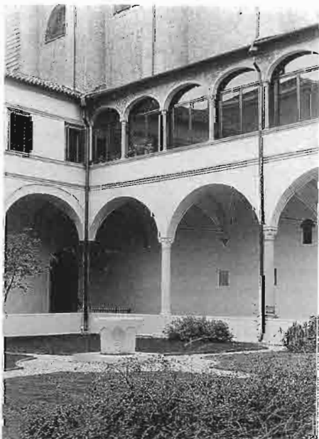
Qui sotto e di fronte, immagini del Chiostro restaurato.
