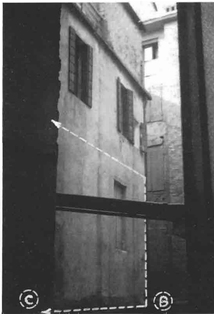
Fig. 4 - Piazza dei Frutti, civv. 40-41: Muro perimetrale del P° 1° della Camatta (lato B-C).
